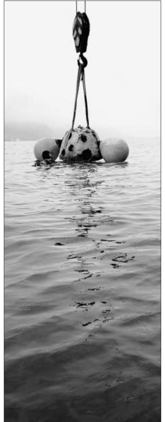
Mit dem Kran werden die Reef Balls ins Wasser gehoben.
