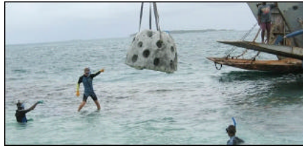
Varios operarios descargan un módulo para un arrecife artificial. La Opinión
