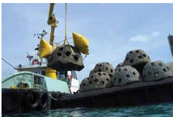
A destra: posa da barca Sotto: posa con cuscini di galleggiamento
