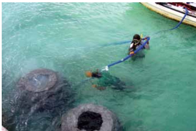
Infissione dei pali di ancoraggio con acqua
