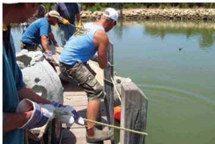
Posa a ridosso delle pareti di un canale
